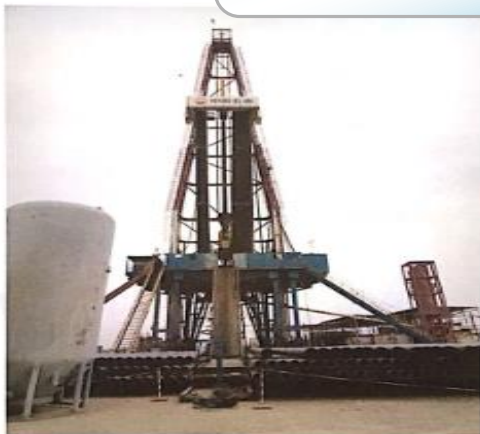
检验机构：新疆通奥油田技术服务有限公司 检验地点：塔里木西部钻探巴州分公司 70139 队
