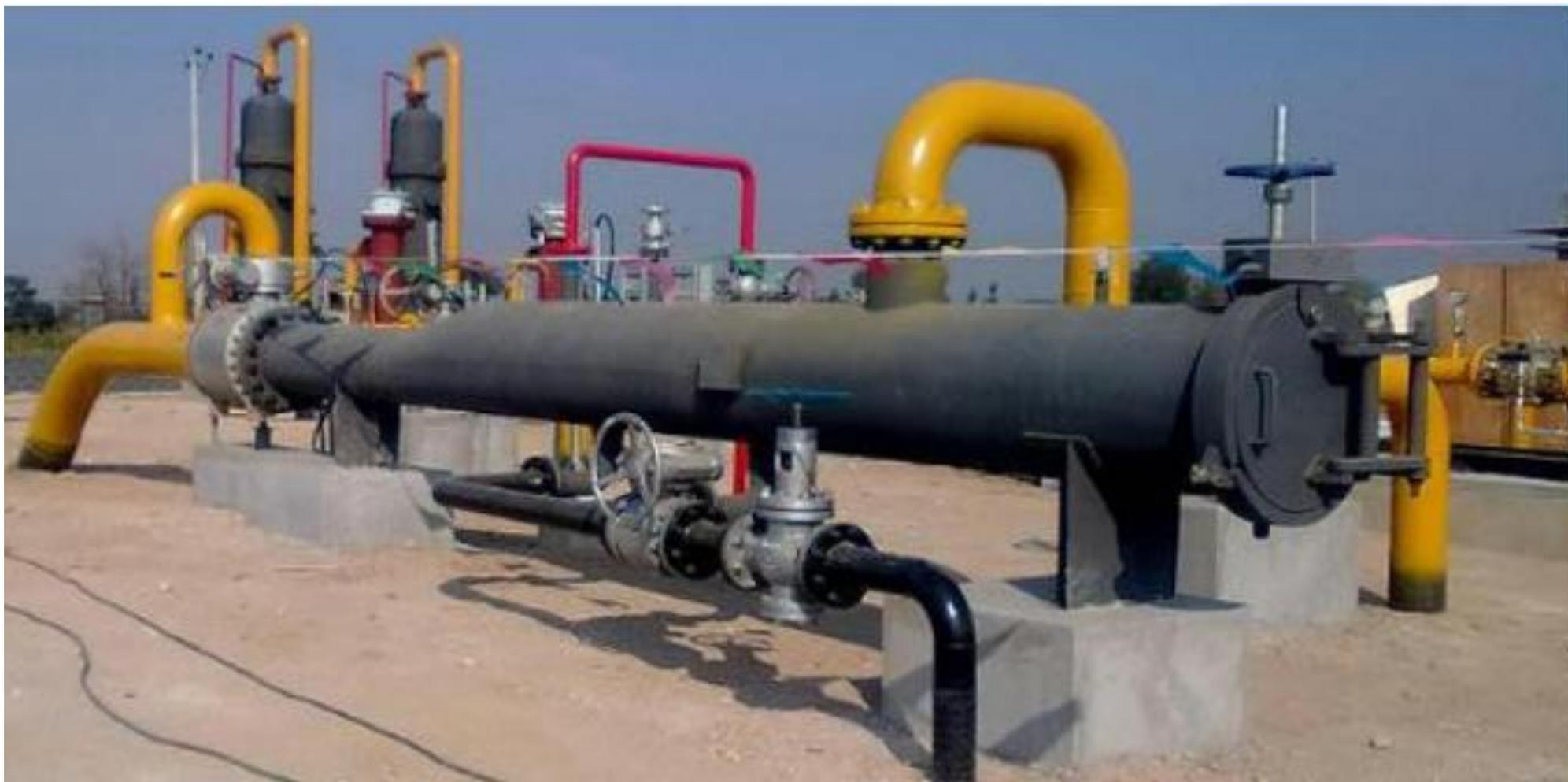
筒体直径比管道直径至少大1-2个等级。筒体长度要大于检测器长度，以方便检测器放入球筒。
